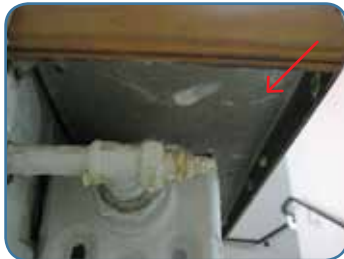
Panel aislante encima del radiador
