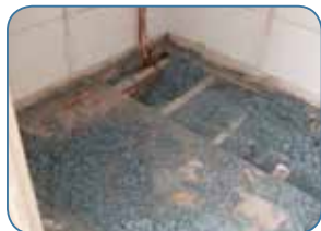
Relleno en el piso (bajo entarimado)
