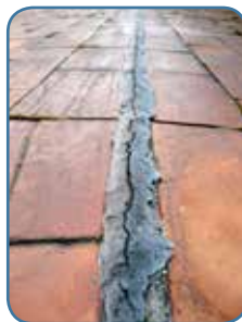
Masilla en junta de dilatación
