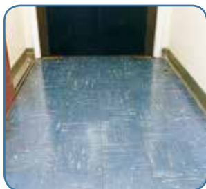
Losetas en pavimento
