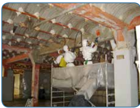
Retirada manual de mortero de amianto 2
